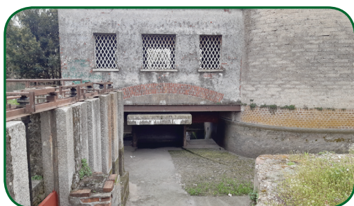
Manufatto Gregotti: come si misura l'acqua
